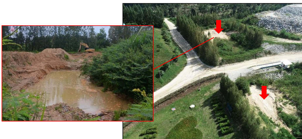
รูปที่ 2.8 บ่อดักตะกอน ขนาดพื้นที่ 1.35 ไร่ ลึก 3 เมตร และ บ่อดักตะกอน ขนาดพื้นที่ 1.5 ไร่ ลึก 3 เมตร
